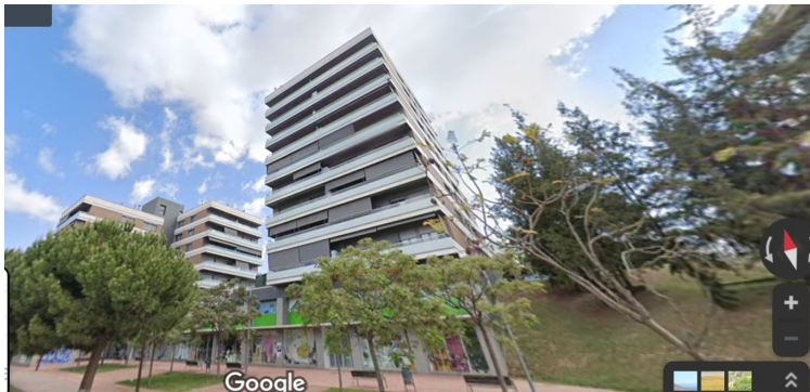
blocs residencials a l'avinguda de Can Corts
