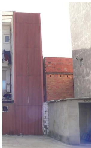
12. Edifici c/Miguel de Cervantes, nº34
