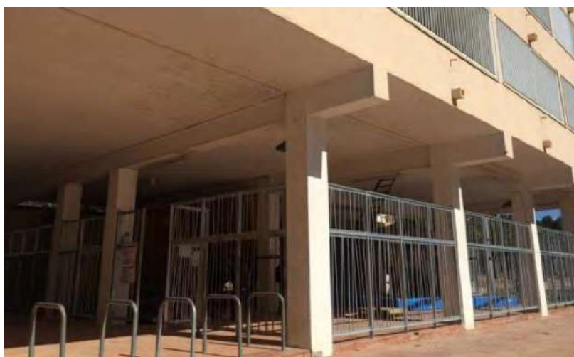
Imagen 4. Fachada sud del edificio dónde se visualizan las instalaciones de escalda interiores
