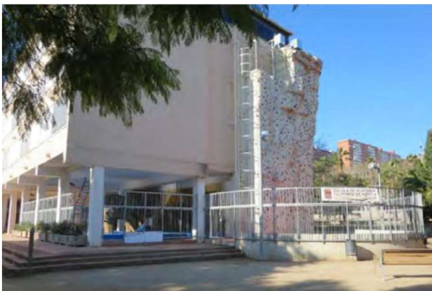
Imagen 2. Testera del edificio dónde se ubica el actual rocódromo
