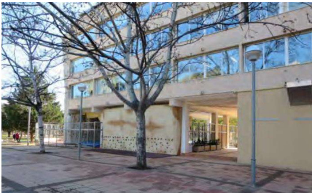
Imagen 5. Fachada posterior del edificio.
