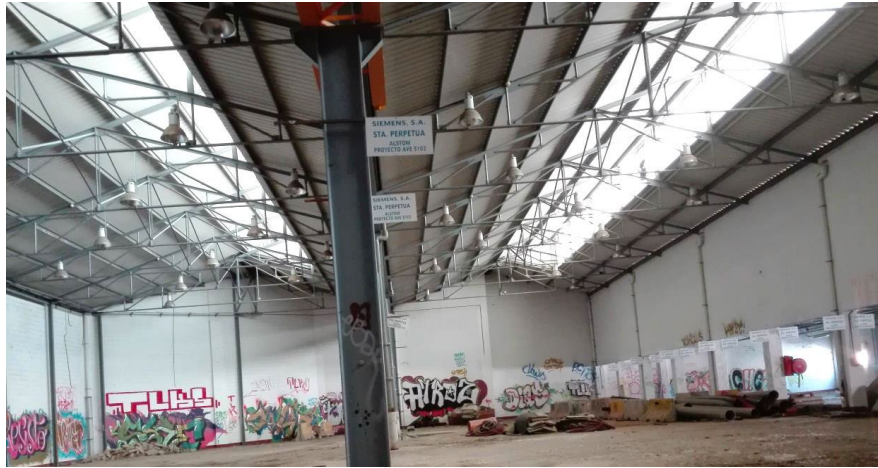
detall de la coberta en dent de serra
