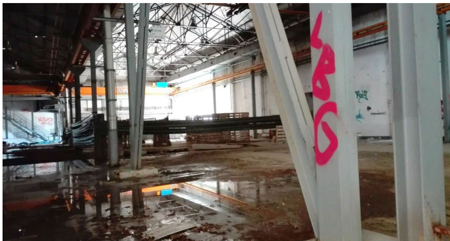
cap al nord-accés al pati de llevat
