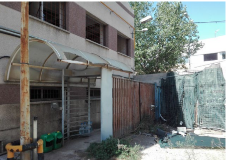
front nord a nau "Caldereria"
